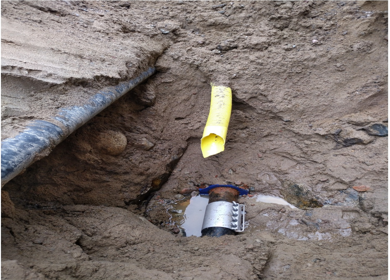
Vesiputken korjaus Karjalantien-Keskustien väli Huom. paikka paikan vieressä.
